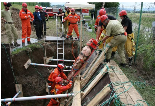
Międzynarodowe warsztaty z zakresu stabilizacji w wykopach
